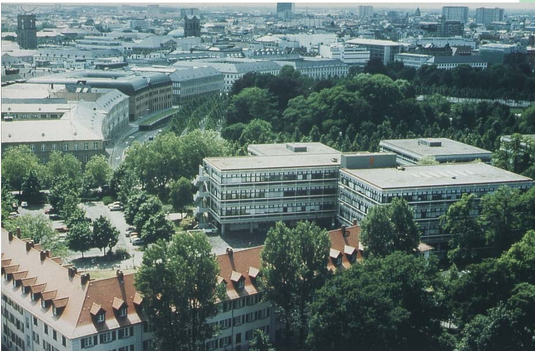
Rechenzentrum der Universität Karlsruhe (TH) aus der Vogelperspektive (Mitte rechts)
